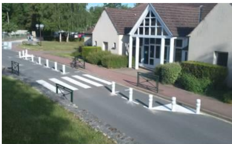
Réalisation (19/06/11) rue du Port
