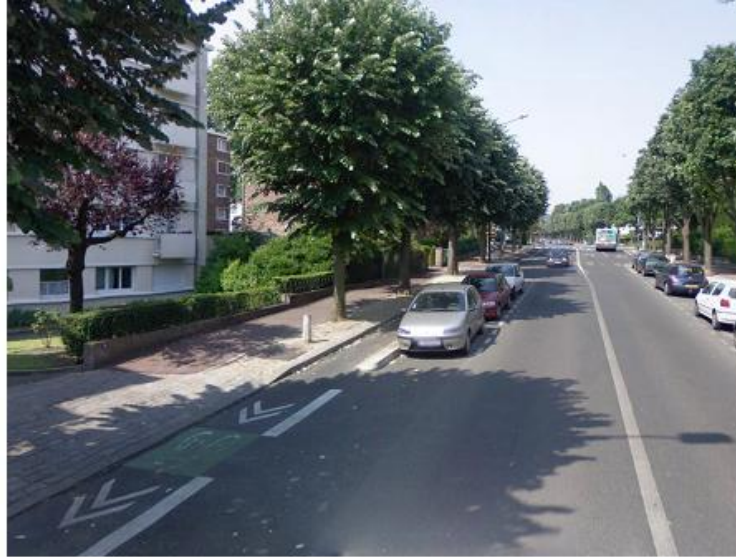
Bd à 50 avec piste entre trottoir et stationnement (Fontenay aux Roses / Sceaux RD 75)
